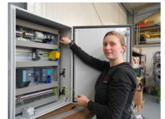
Auszubildende Eyleen Redeker übernimmt bereits die Montage der Elektrokomponenten
